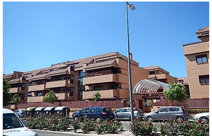
Fotografía de fachada
